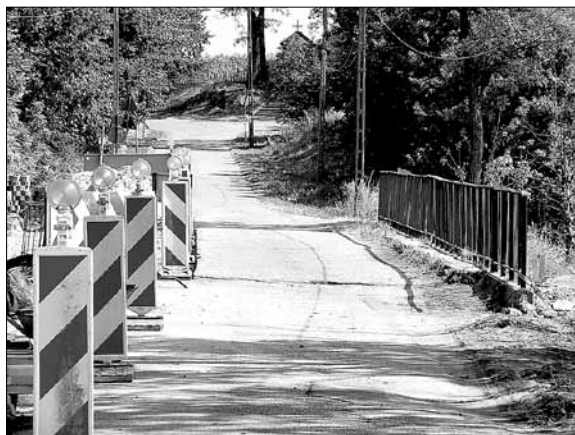
Modernizacja mostu w Pawłowicach
