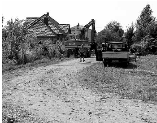
Budowa kanalizacji deszczowej na ul. Koralowej w Paprotni
