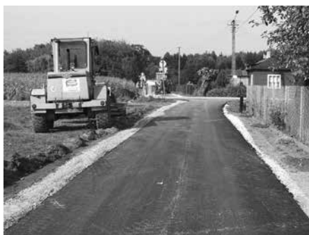
Droga w Witoldowie
