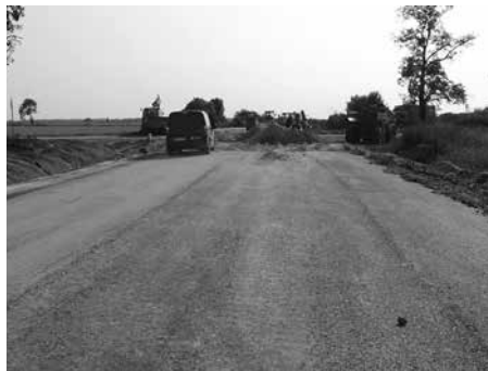
Na budowie II odcinka „obwodnicy”
